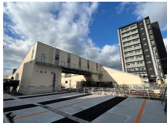
外観(自由通路)
