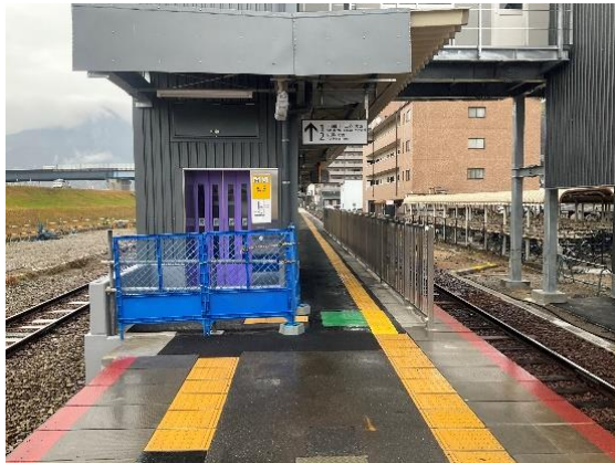
安芸矢口駅のエレベータ
