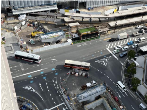
高架橋の下部工事
