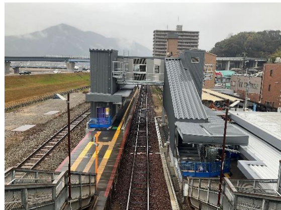
安芸矢口駅のご線橋
