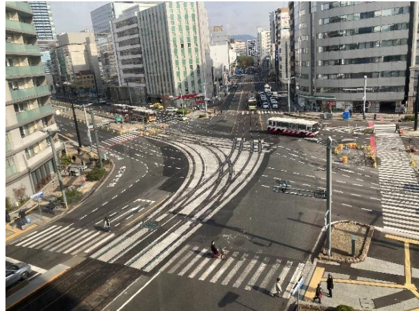
稲荷町交差点の改修作業
